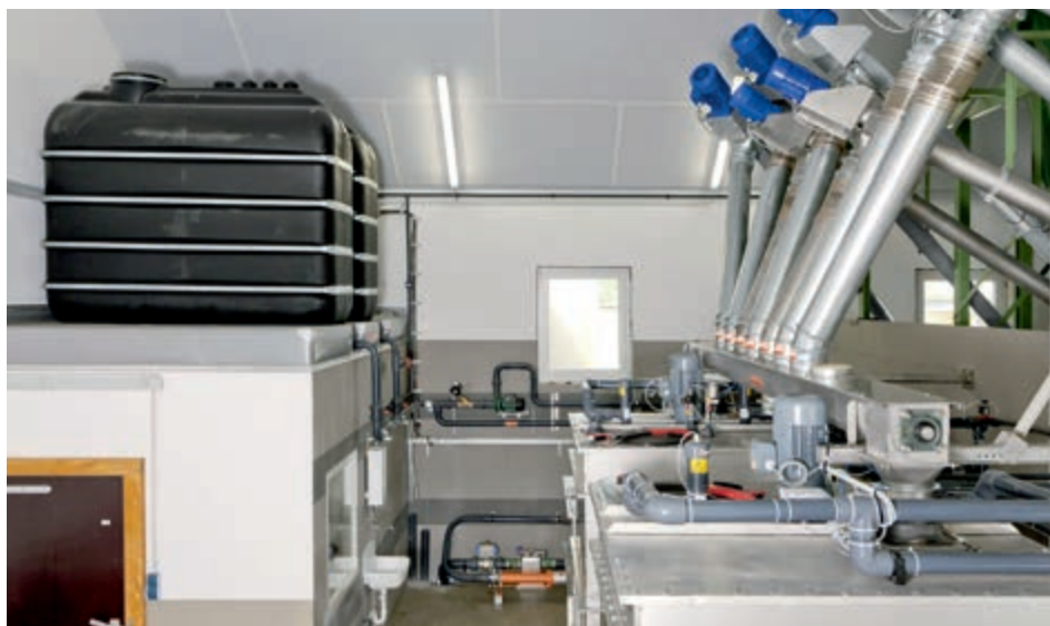
Futterküche mit einer 2-Tank-Restlosfütterung und zwei 2000 l-Frischwassertanks
