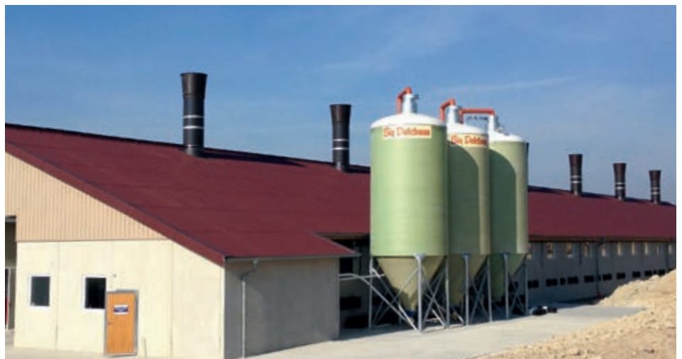
Beispiel: Austritt der Abluft > 3 m über First
