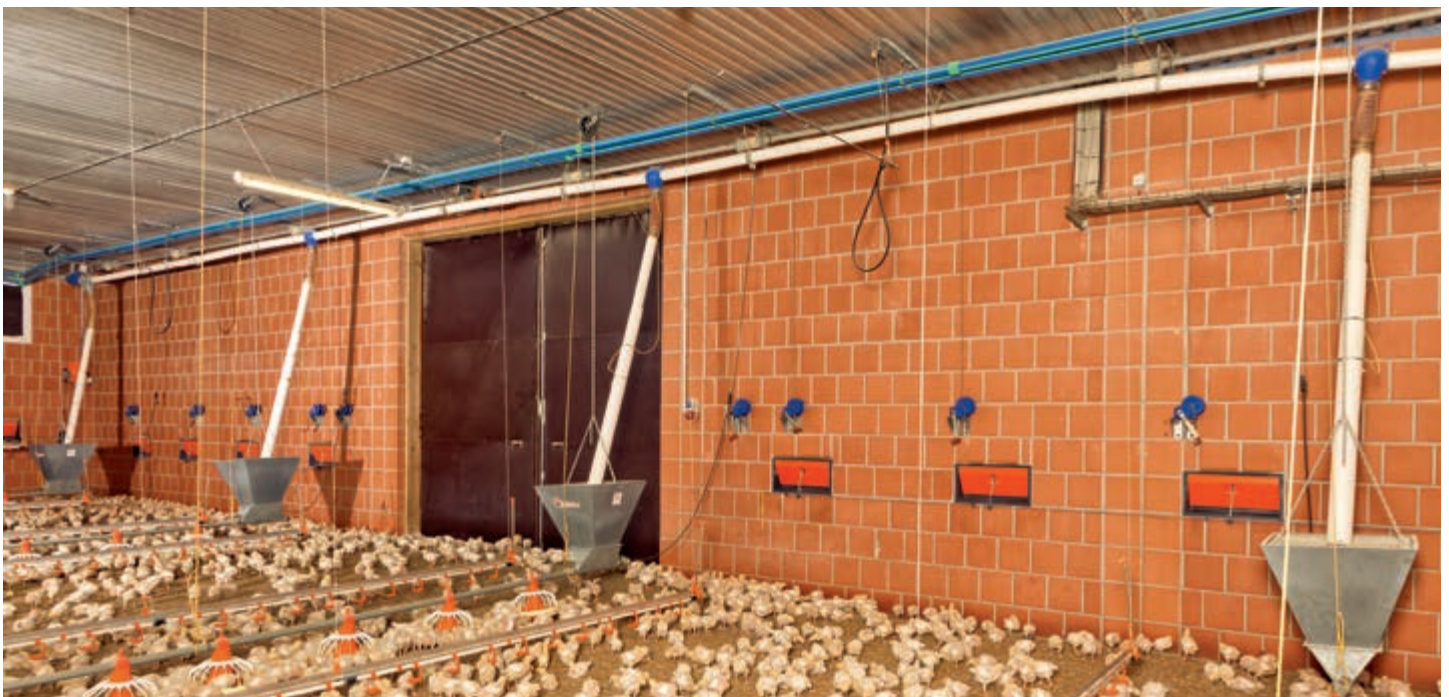
Kabelwinden unter anderem zum Einstellen der optimalen Höhe der Tränkelinien entsprechend dem Alter der Tiere
