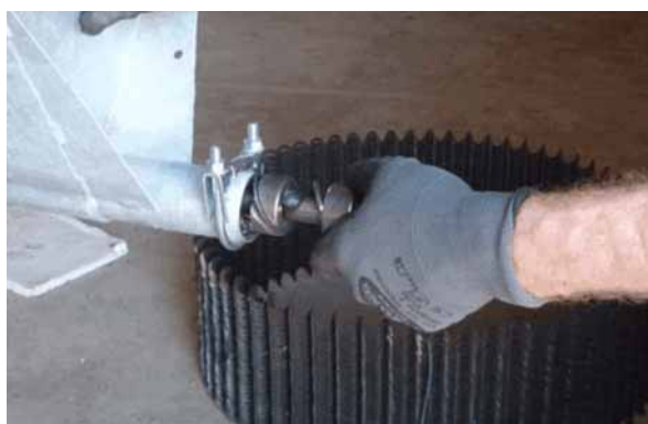
Rys. 6-8: Przytrzymywanie wału napinającego
