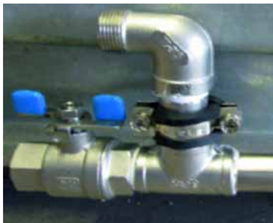
Bild 6-1: Kugelhahn geöffnet
