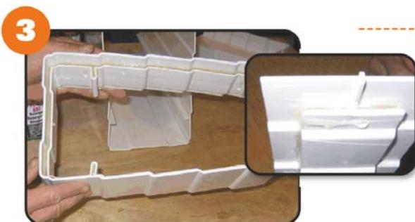
3. Drehen Sie die Kupplung um und füllen Sie den Spalt auf der anderen Seite **komplett** mit Tangitklebstoff aus.
